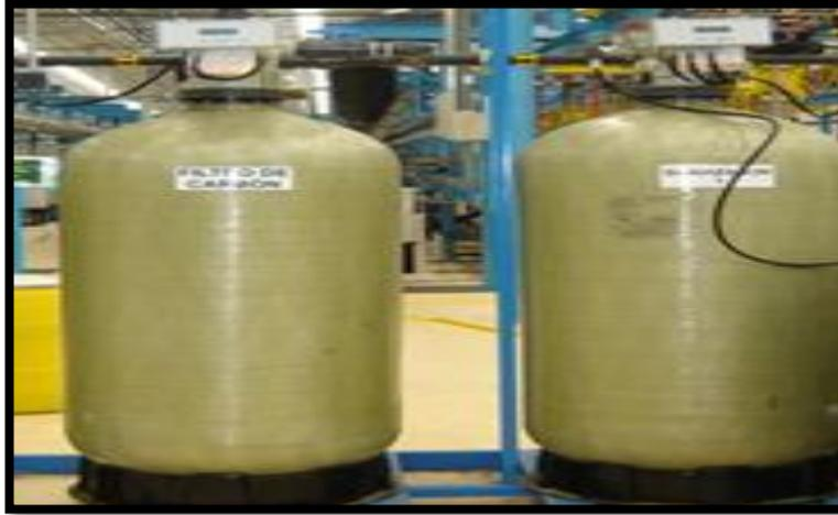
**Figura 8 Filtros de carbón activado**
