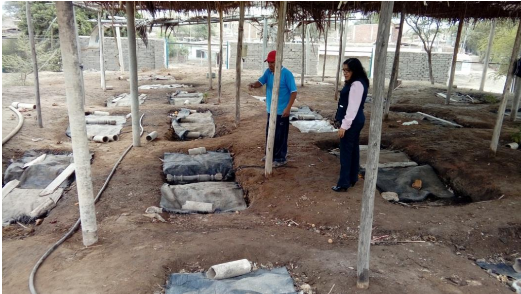
Figura 11: Adecuación de composteras donde se realizará el compost, el área tiene que ser adecuado en el que se va añadiendo la materia prima que, poco a poco, se convertirá en compost.
