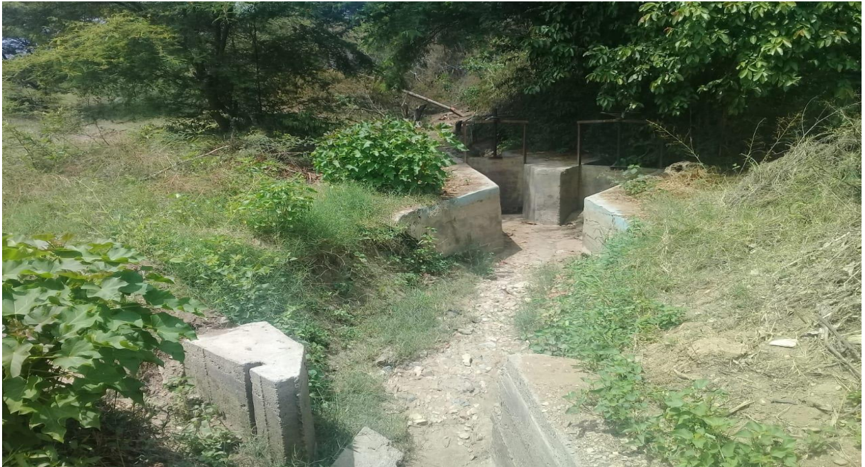
FIGURA 12: Fotografía de canal de aguas superficiales ubicado a pocos metros de las lagunas de estabilización, cuando se realizó la visita estaba seco, pero si hay corrientes de aguas a partir de los meses de junio y épocas de lluvia.
