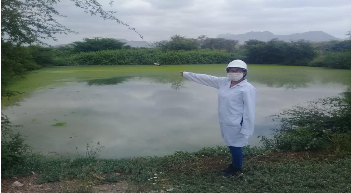
FIGURA 6: Laguna número 01, los afluentes han superado la capacidad máxima de retención de la laguna de estabilización, siendo un peligro de desborde, está rodeada de vegetación y la mayor parte de la superficie está cubierta de algas, residuos sólidos y costras.
