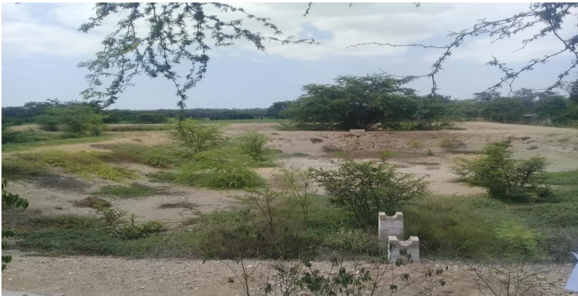
FIGURA 5: Vista de las lagunas 3 y 4, en total abandono y cubierta de vegetación.
