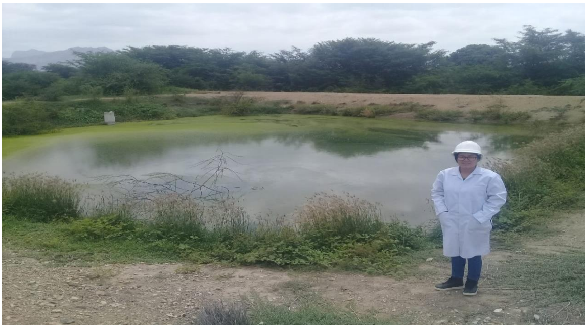
FIGURA 7: Laguna número 02, cuenta con condiciones muy parecidas a la primera, vegetación en los alrededores y dentro de la laguna, residuos sólidos, tubería rota y gran parte de la superficie cubierta de algas y costras.
