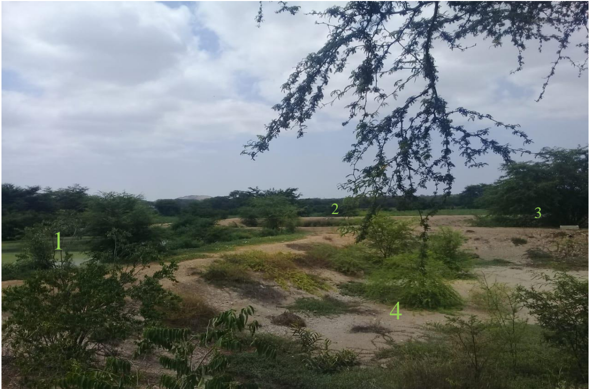
FIGURA 4: Vista panorámica de las 4 lagunas de estabilización del Centro Poblado la Otra Banda, se puede apreciar la gran cantidad de vegetación que ha emergido, opacando las construidas lagunas.
