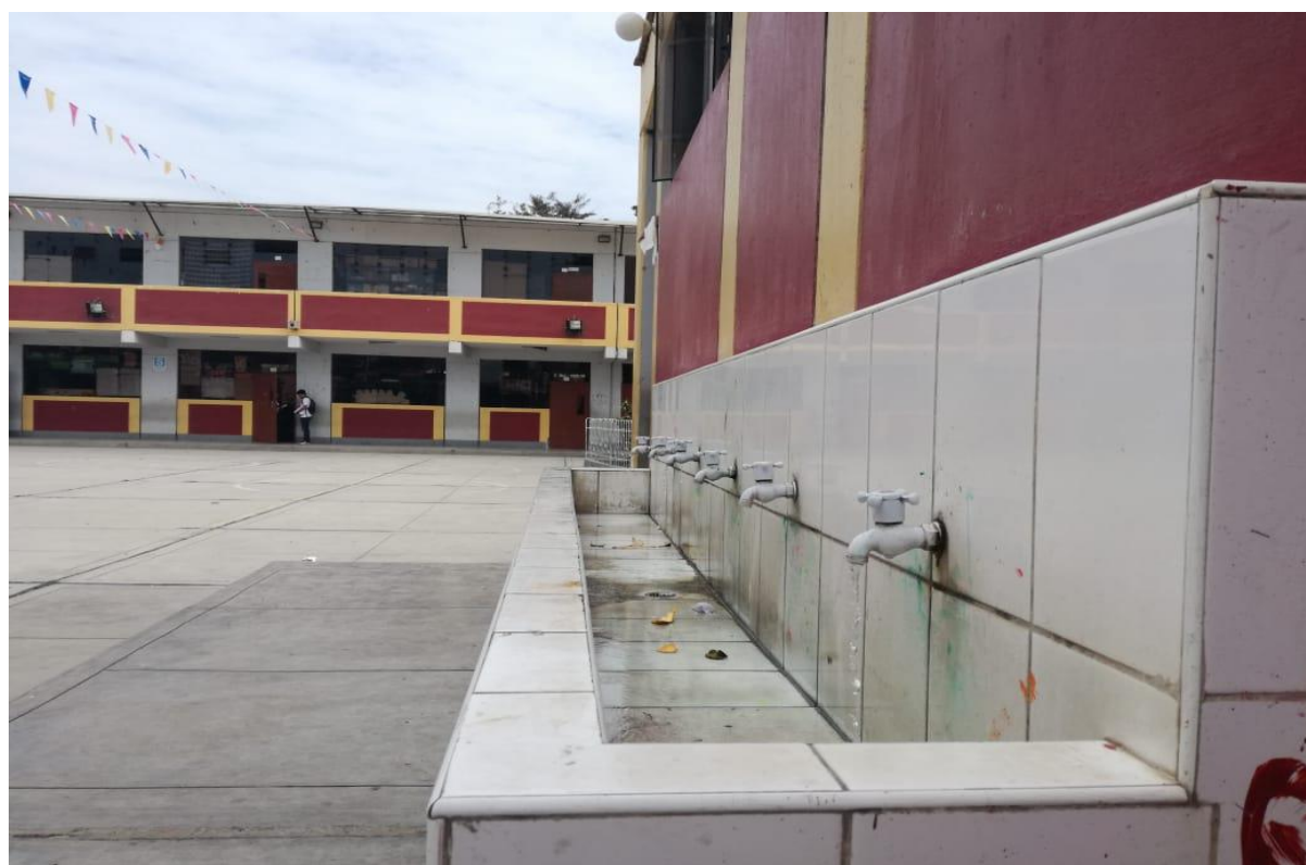
Anexo 4. Lavatorio N° 1 de la I.E. Tacna N° 11501.
