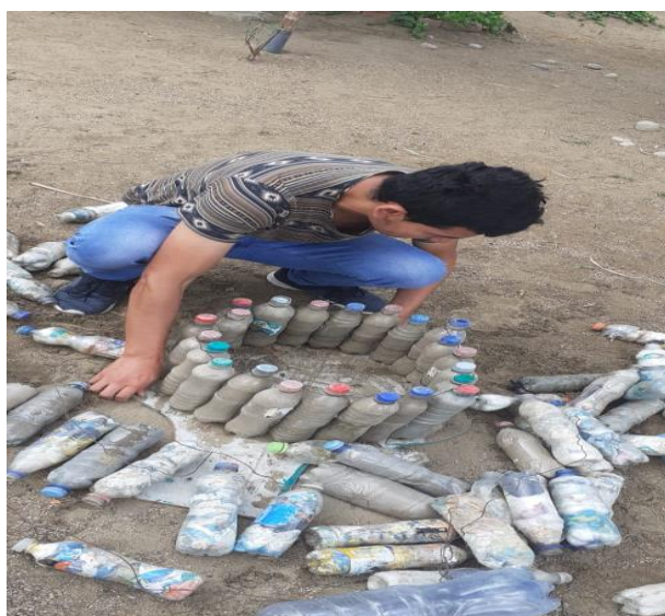
Figura 13. Elaboración de estructuras con ecoladrillos
