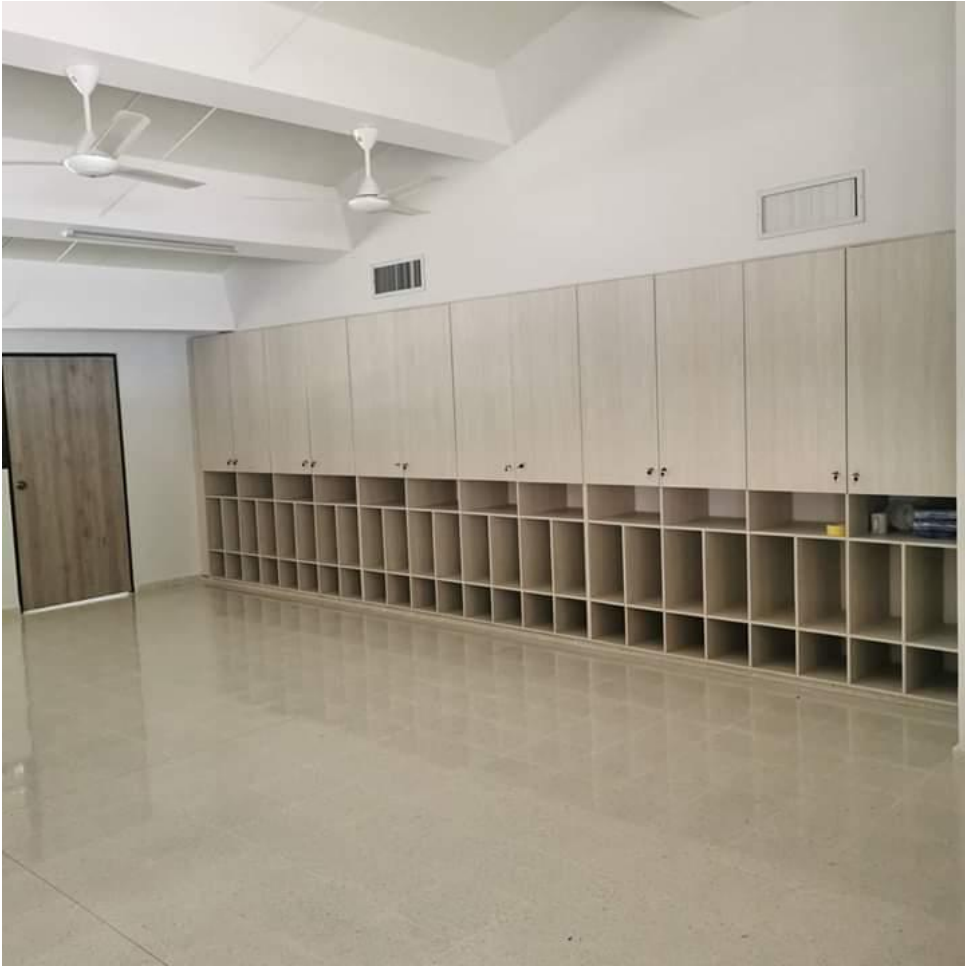
Imagen para la instalación de un locker
