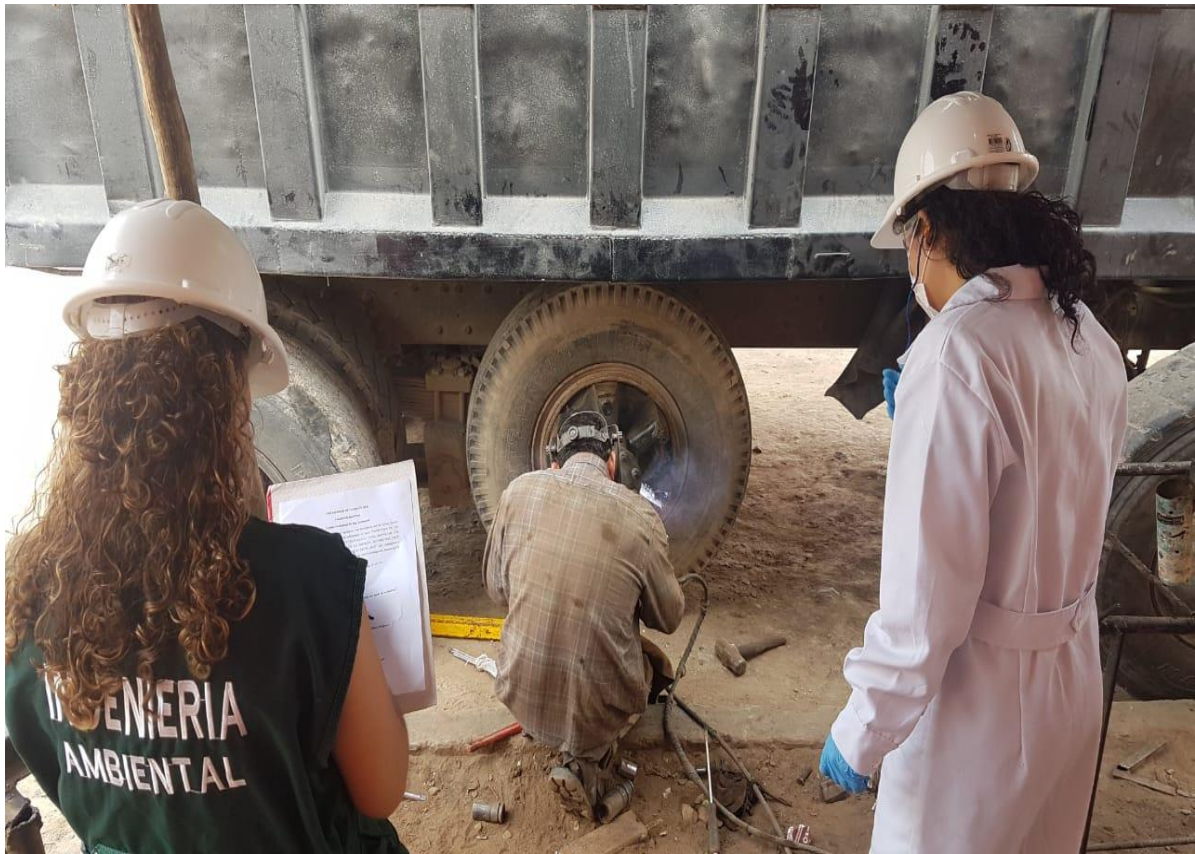
Figura 27. Inspeccionando si los trabajadores cuentan con sus EPP's
