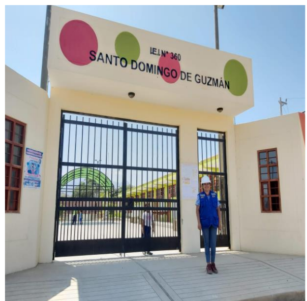
Fotografía N° 8 - Identificación de estado de conservación en Instituciones Educativas
