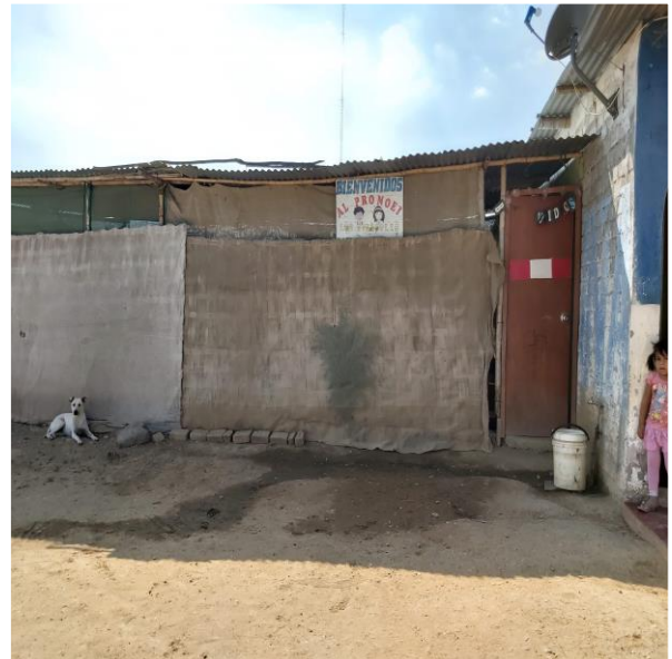
Fotografía N° 6 - Identificación de estado de conservación en Instituciones Educativas
