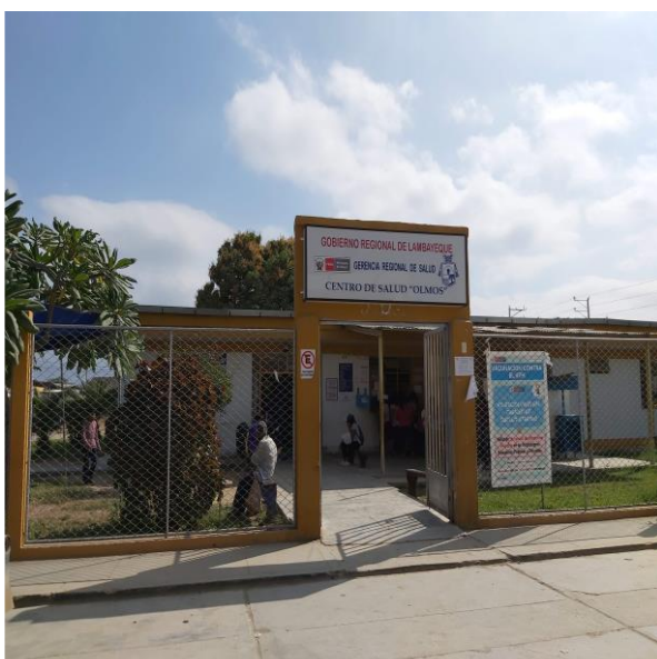
Fotografía N° 7 - Identificación de estado de conservación en Centros de Salud
