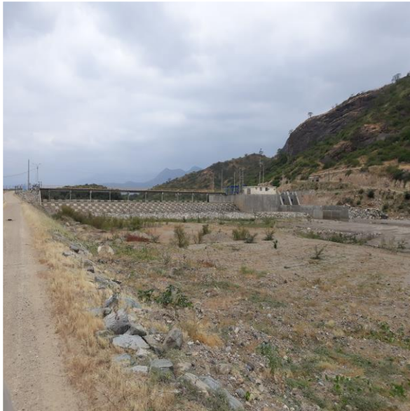
Fotografía N° 1 - Identificación de infraestructura hidraulica
