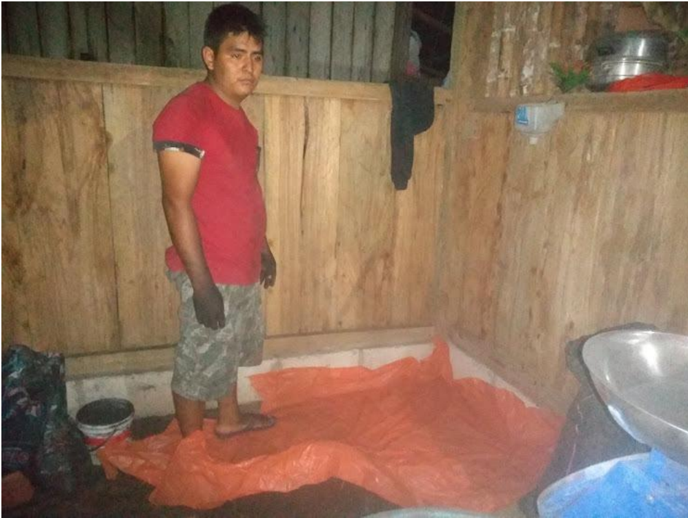
Figura 1. Acondicionamiento del área
