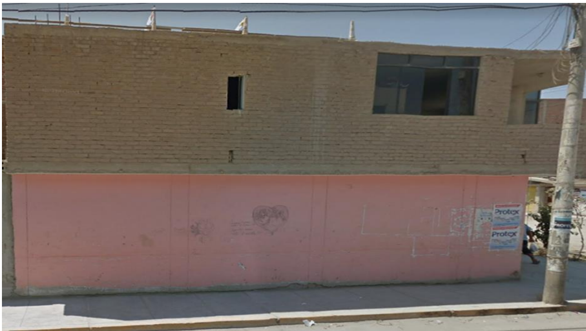
Figura 19. Fachada por remodelar.
